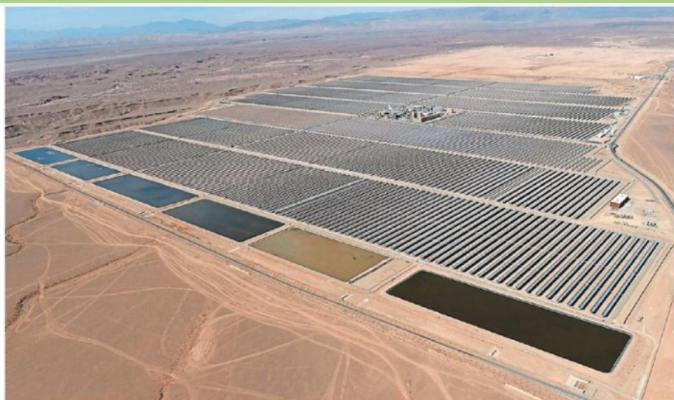
Le Maroc possède à la fois de l'espace, du soleil et du vent. De quoi développer les énergies renouvelables, comme ici la centrale solaire à concentration Noor 1, près de Ouarzazate.
